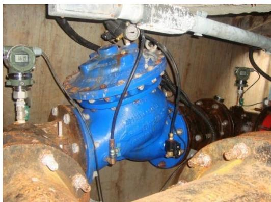
**Figura 9 – Válvula Redutora de Pressão**
