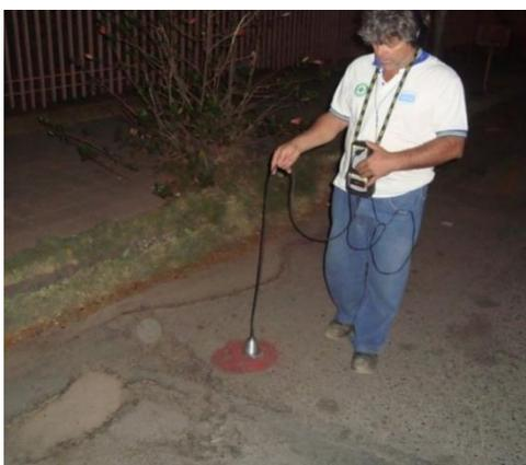
**Figura 16** – Utilização de equipamentos na identificação de vazamentos
