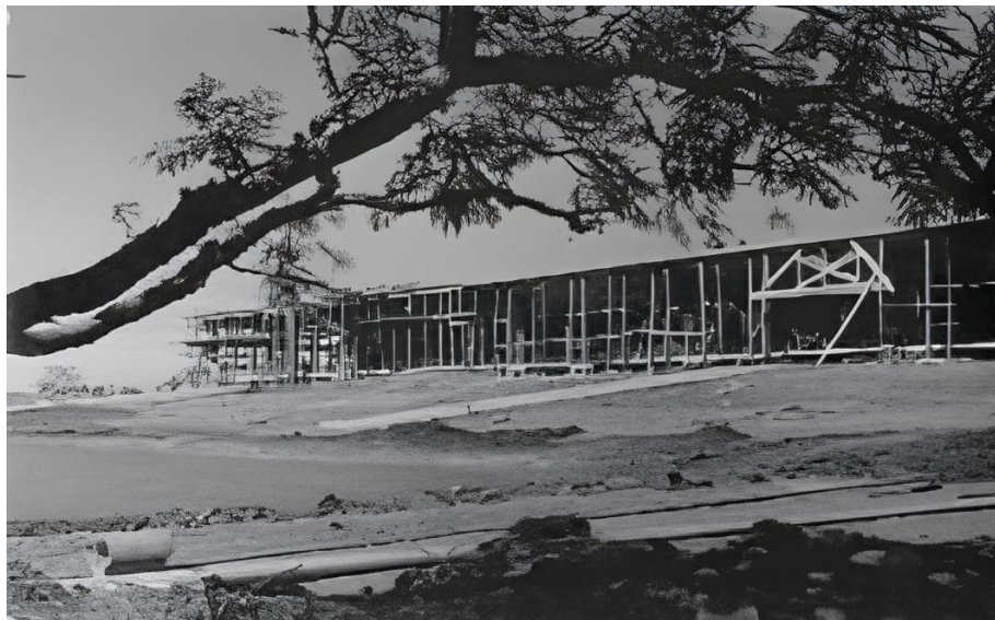
Figura 09: Vista externa da Faculdade de Educação (FE 1) em construção, com madeiras de escoramento.
