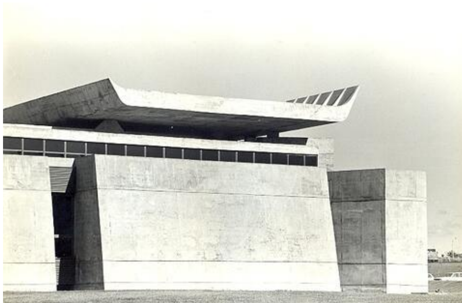
Figura 12: Fachada da Biblioteca Central (BCE). Vista lateral
