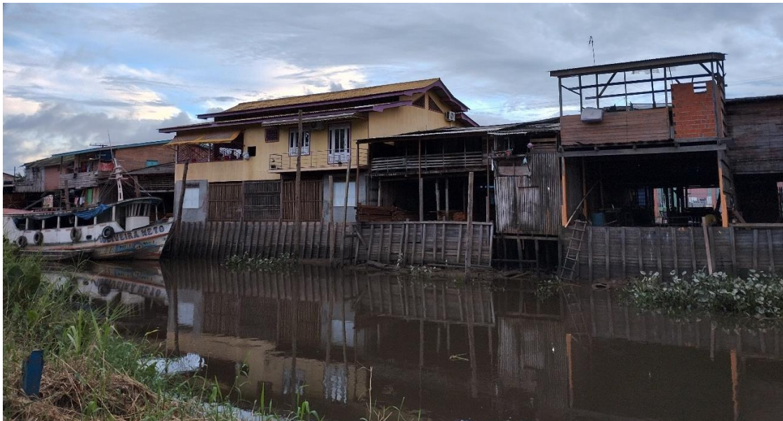
Figura 2: Tipos de Residências observadas no local.
