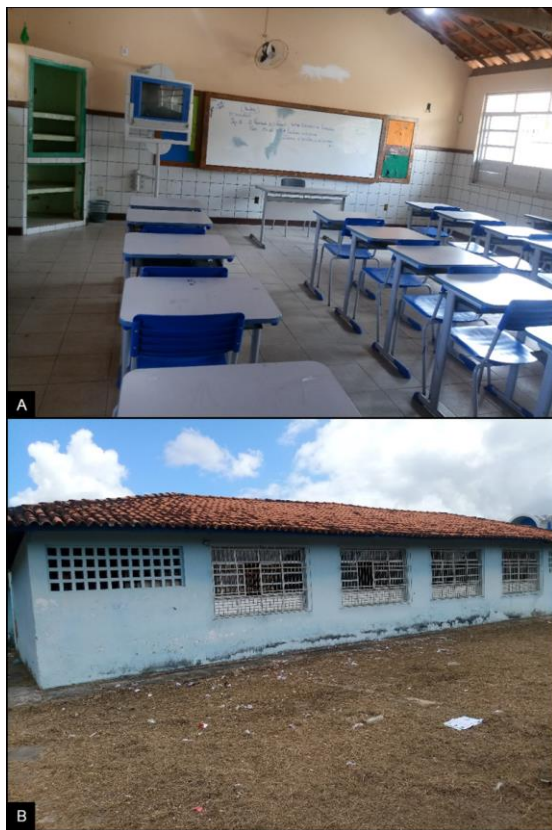
Figura 2: Infraestrutura de Escola sediada no município de Alagoinhas (BA)
