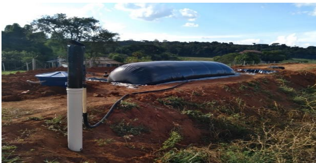
Figura 4 - Biodigestor da Fazenda Escola Retiro da Unifenas
