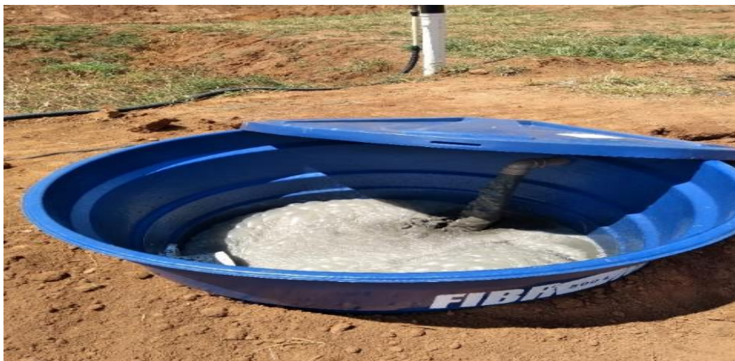
Figura 6 - Reservatório de entrada dos dejetos suínos ou afluente
