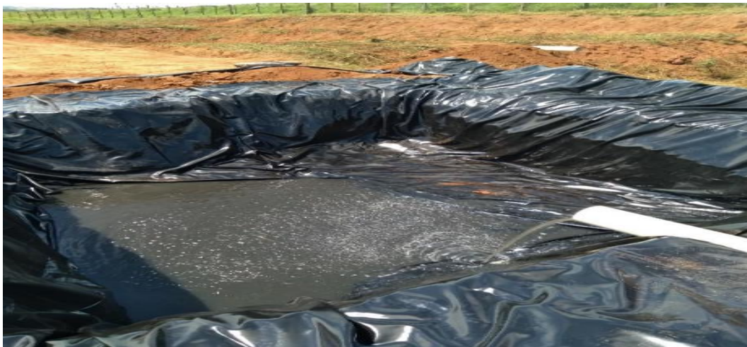
Figura 7 - Reservatório de biofertilizante ou efluente
